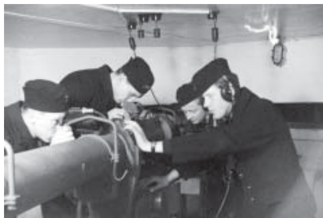
Kustartillerister vid Gnetaröds mätstation observerar Öresund genom optiken på en 4 meters inbasmätare
