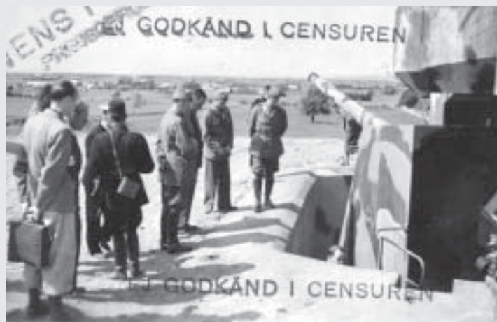
Det rörliga kustartilleriet skulle ersätta eller komplettera det fasta kustartilleriet. Här ses en av Batteri Helsingborgs 15,2 cm kanoner m/40 inbyggd i bunker.
