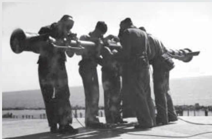
Fyra meter inbasinstrument m/46, användes för inmätning av luft- och sjönmål. Mättekniken förutsatte att den mätande personalen hade förmåga till stereoskopiskt seende.
